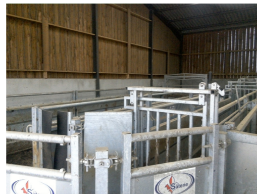
Vue d'ensemble du parc de contention
